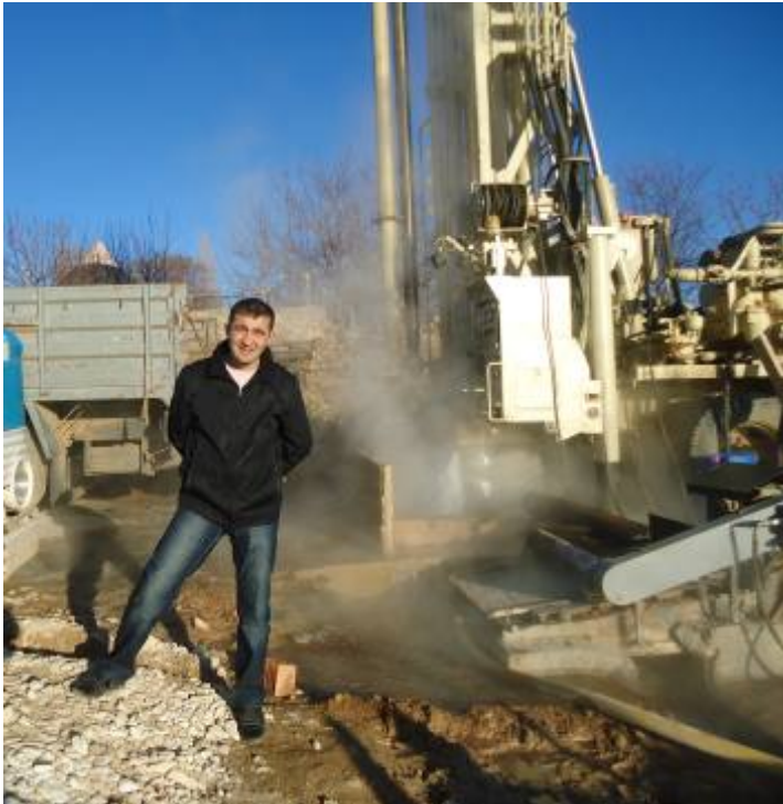
Terme Jeotermal alanında yapılan sondaj çalışması
