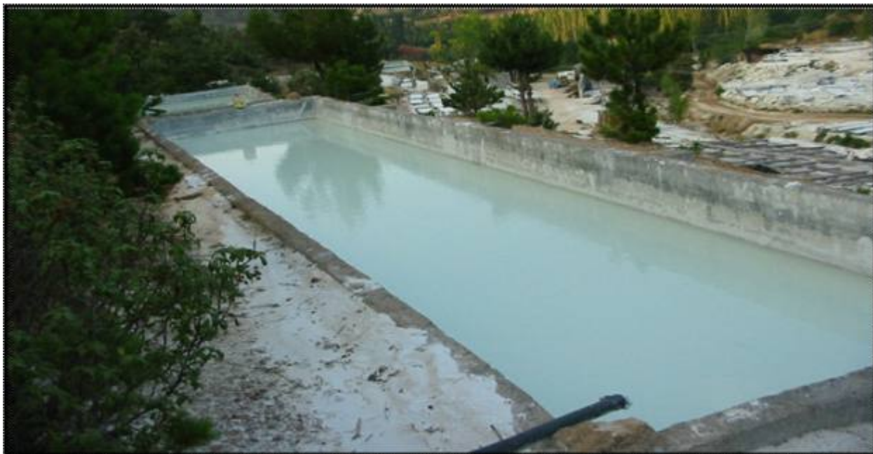
Şekil 5. Kaolen yatağı işletmesi bekletme havuzu
