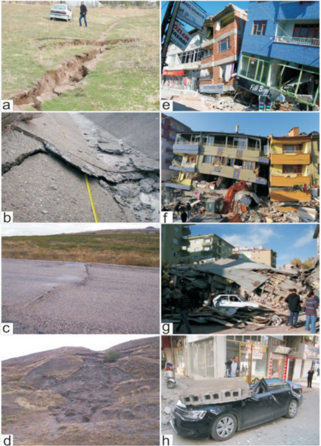
Şekil 7. Van depremi ile ilgili olarak basında çıkan resimler ve fotoğraflar. a) Depremi ardından oluşan tansiyon çatlakları, b,c) fayın bir bindirme fayı olduğunu gösteren yükselimler, d) deprem sonucu gevşek yamaçlarda meydana gelen heyelanlar, e,f) yumuşak kat düzensizliği sonucu çöken evler, g) tamamıyla çöken evler, h) evlerin yıkılmadığı bölgelerde meydana gelen maddi hasarlar (YTU., 2011)
