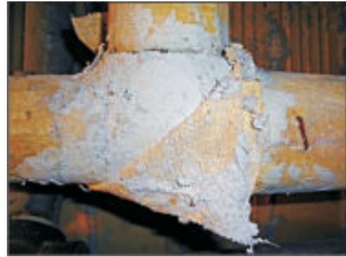
ekil 11. Sıcak su ve buhar borularında izolasyonda kullanılması. ( http://www.flickr.com/photos/asbestos_pix/6808422842/in/photostream/ )
