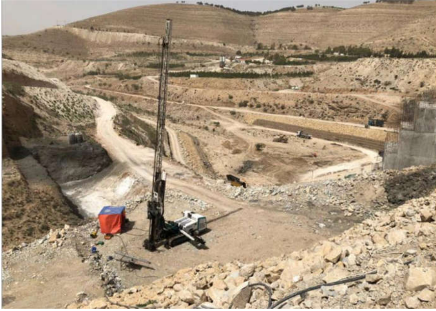
Baraj Alanında Zemin İyileştirme (Jet Grout) Çalışmaları (Eski mezunlarımızın arşivinden)
